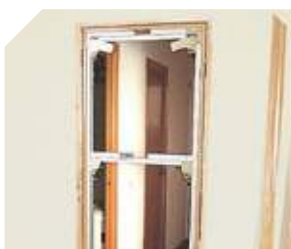
Colocação do PB83E, ajustado ao pré aro
