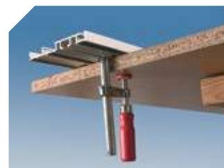
Dois sargentos para fixação da guia pela parte inferior.
