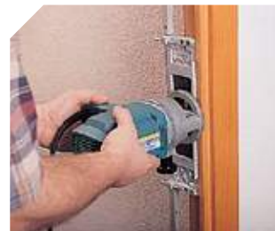
Colocação de dobradiças com o cabeçal CPN66.
