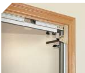
Aplicação dos tapa juntas com os guias de topo preparados para esse fim
