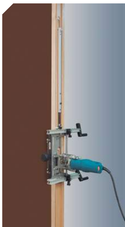
Realização do segundo rasgo no aro.
